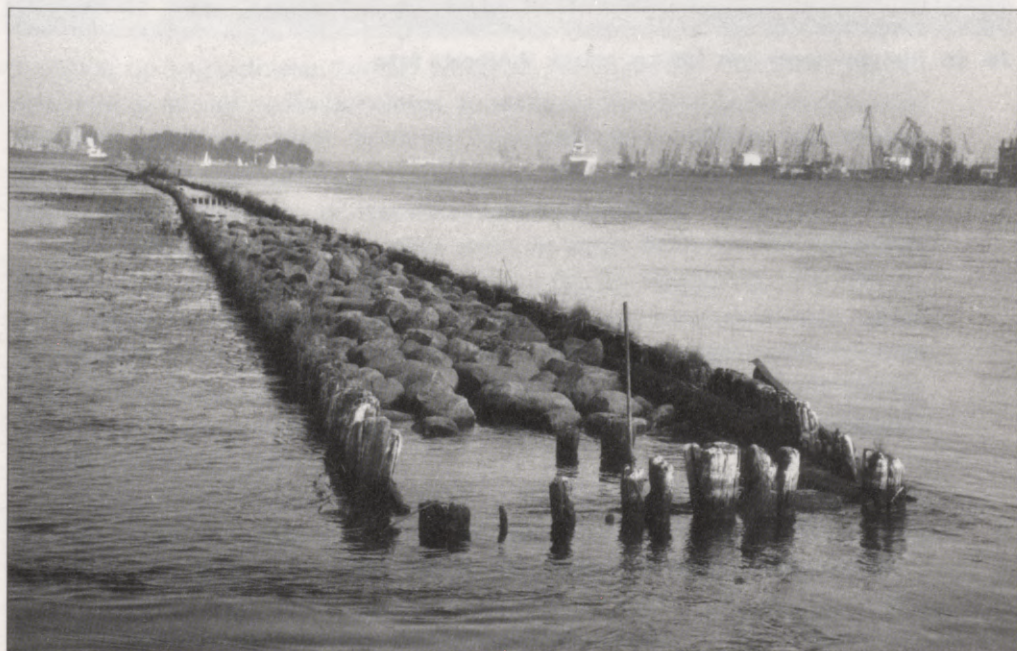
55. att. FG dambis 1997.g. augustā
