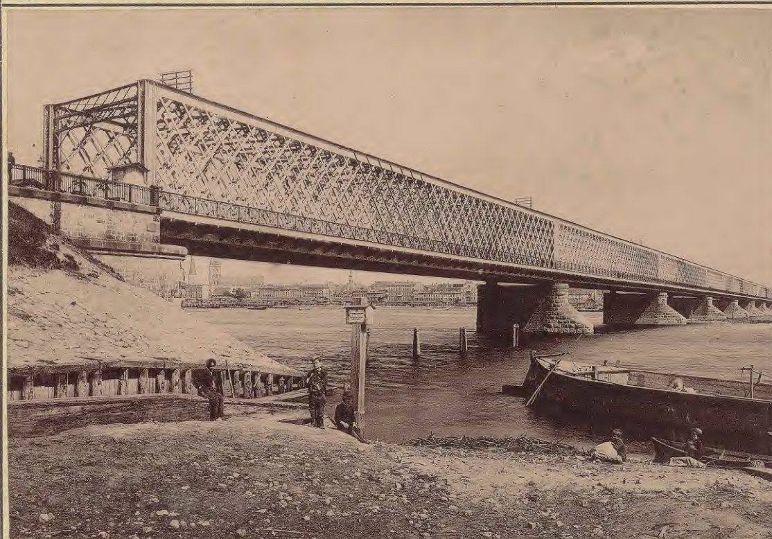
Рига. — Желѣзно-дорожный мостъ.
