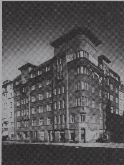
Īres nams Rīgā, Lāčplēša ielā 51, 1909
