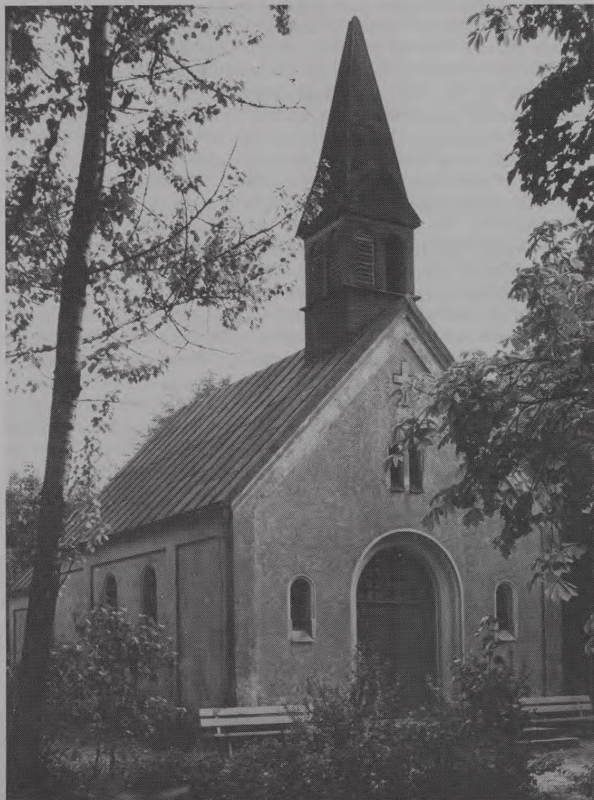
Sv. Pāvila baznīcas draudzes kapsētas kapliča Rīgā, 1927
