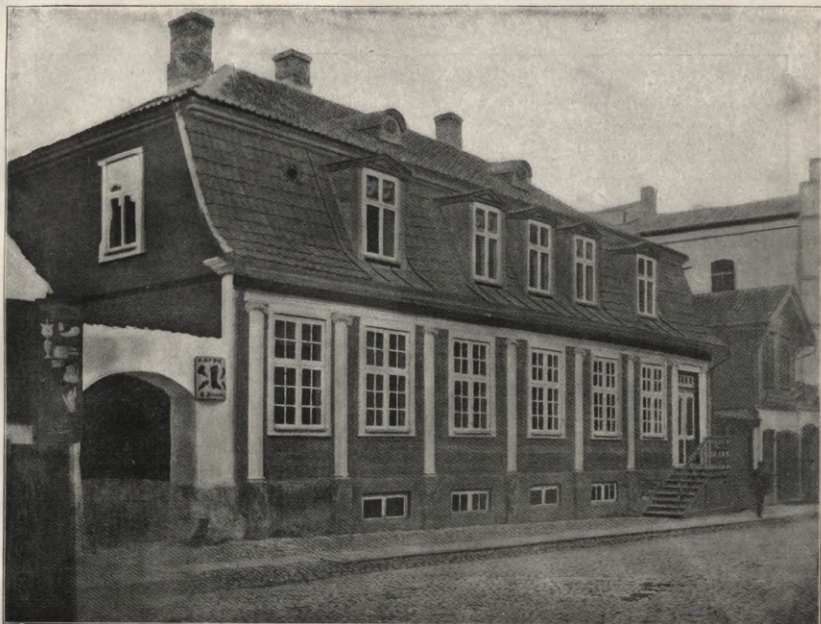
Wenden in Livland: Das Haus Heinrich von Meyer, erbaut etwa 1800, ein dunkler, unbelieferter Holzbau mit weißen Säulen, Sims und Fenstern
