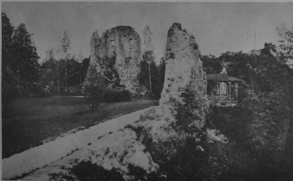
52. Die Ruine der Ordensburg Segewald. Die erste Feste, welche die Schwertbrüder außerhalb Rigas erbauten. Bis 1432 ist sie Ordenskomturei gewesen, dann später Sitz des Landmarschalls.
