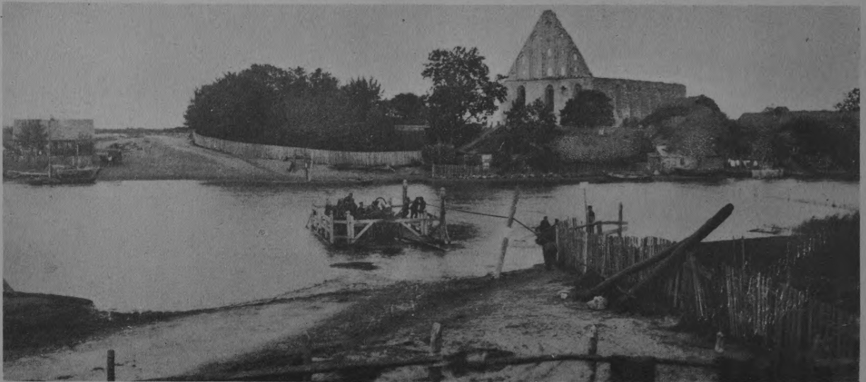
50. Ruine des St. Brigittenklosters in Estland. Das Kloster wurde zu Beginn des 15. Jahrhunderts erbaut und von den Russen 1575 zerstört.
