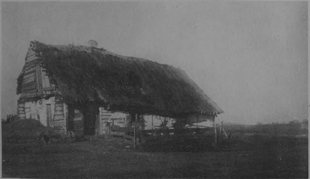
19. Ein typisches litauisches Bauernhaus. Auffallend ist die Verfallenheit dieser Häuser. Fast alle bestehen aus Holz und sind mit Stroh gedeckt.
