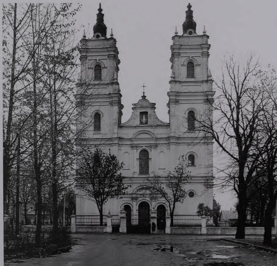
3. Baznīcas fasāde. Foto: 1985, PDC
