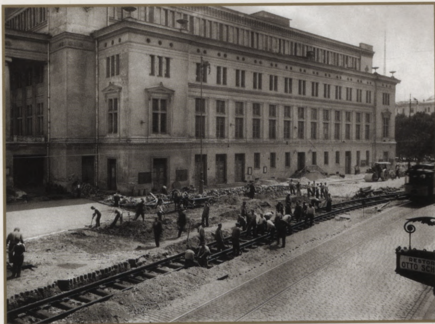
Tramvaja sliežu ceļa remonts un asfaltēšanas darbi Aspazijas bulvārī. Nezināms fotogrāfs, 1935. RVKM.
