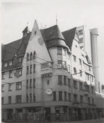
186. Īres nams Rīgā, Brīvības ielā 47. 1908. Arhit. E. Laube
