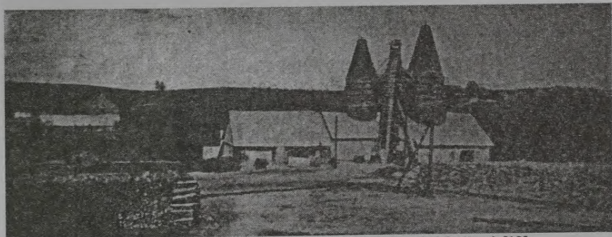
82.att. Nīgrandes stāvceplis cehšteina kaļķakmens apdedzināšanai. [12]
