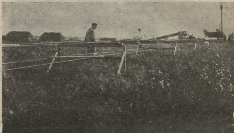
Zīm. 70. Ar tvaika spēku nodarbināmas kūdras mašīnas drāšu virvju novedējs. Tālumā redzama kūdras mašīna ar lokomobili.
