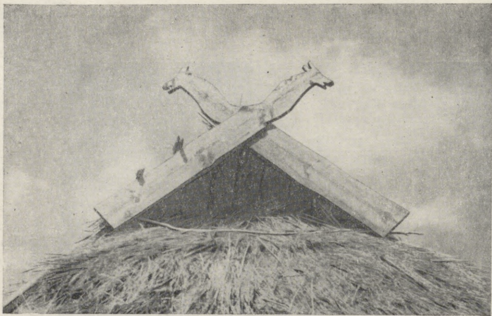
65. att. Dzīvojamās ēkas salmu jumts ar brodiņiem un jumta āžiem (Liepājas rajonā).
