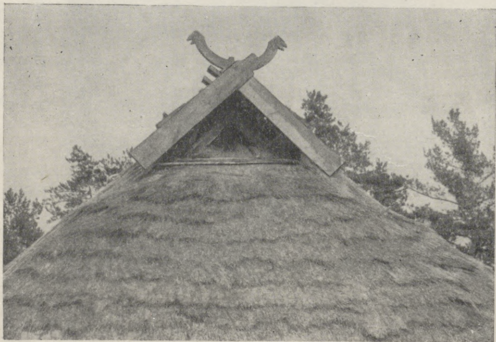
66. att. Dzīvojamās ēkas niedru jumts ar brodiņiem un jumta āžiem (Liepājas rajonā).
