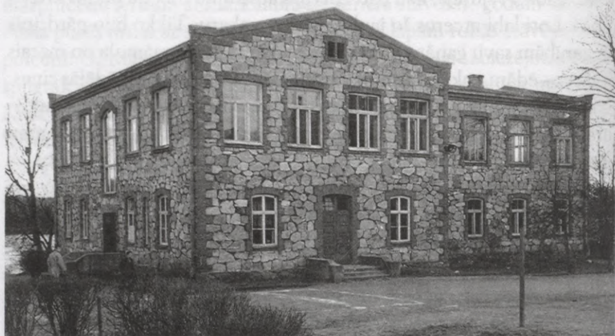
Pļaviņu ģimnāzijas ēka, ekspluatācijā nodota 1934. gadā. 1970. gada foto
