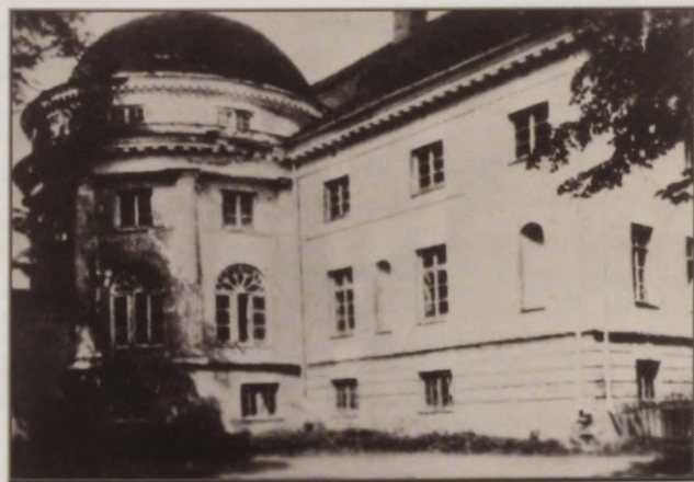
Pils 20. gadsimta sākumā. Attēlā redzams 1935. gadā nodegušais jumta kupols un augšējais pusstāvs, kurš pēc ugunsgrēka nav atjaunots.
