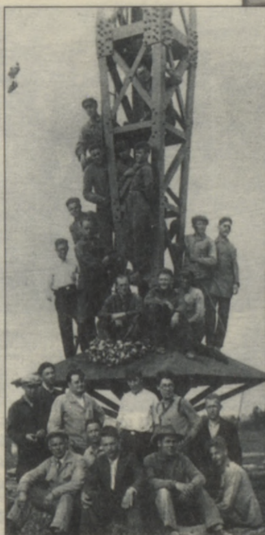
Kuldīgas raidītāja antenas masts – latviešu inženieru projektēts, Liepājas drāžu fabrikā būvēts un Latvijas radiofona speciālistu samontēts (1934.).
