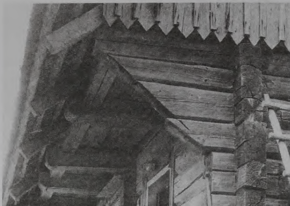
3. att. Grūslēnu dzīvojamās mājas jumta pārkares konstrukcija.
