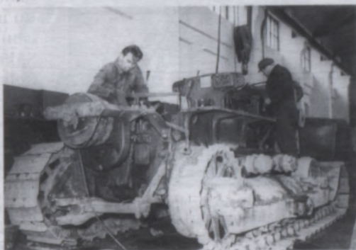
Ceļu mašīnas remonts mehāniskajās darbnīcās. 1956.g. TMNM 4439
