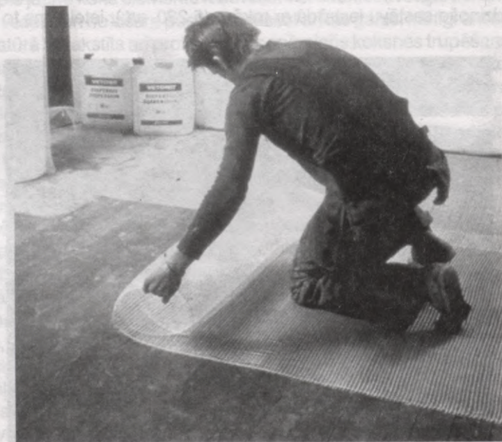
5.231. att. Stiklšķiedras auduma ieklāšana pirms grīdas izlīdzinošā sastāva iestrādāšanas
