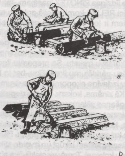
5.5. att. Kokmateriālu apstrāde ar antiseptējošiem šķīdumiem: a – ar otu; b – ar krāsotāju otu
