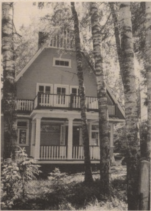
Vasarnīca Ausekļa ielā. 1989 Foto no E. Upmaņa arhīva
