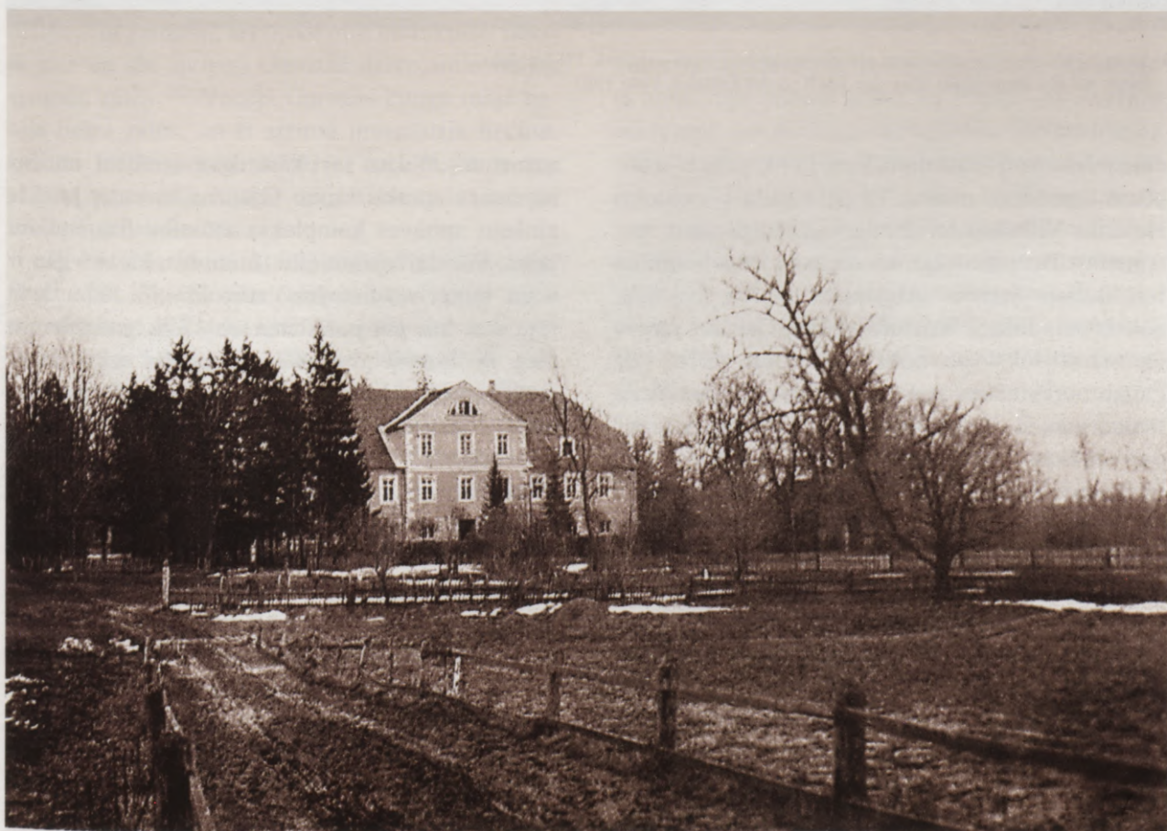
2. Skats uz kungu māju no rietumu puses ganību cēla. 1917. g. foto Blick auf das Herrenhaus von dem westlichen Weidenweg. Foto 1917
