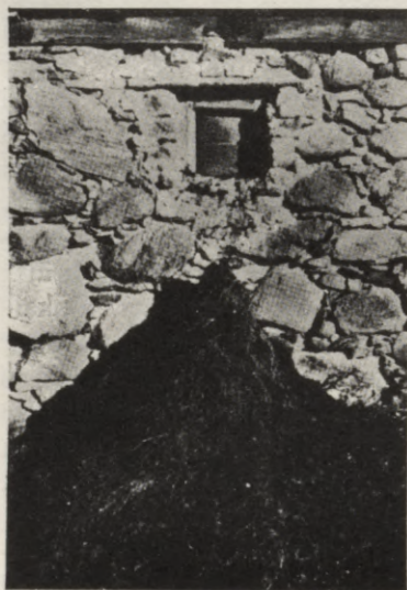
23. att. Caur īpašu lodziņu kūts sienā (kas noslēdzams ar aizbīdni) zirgu mēslus izmet sutrainī. Cērē, 1937.g. (Autora uzņ.)
