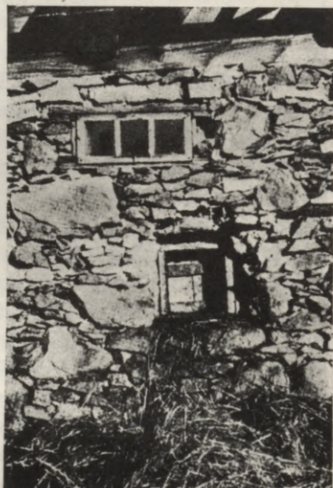
24. att. Sutrainis . Netālu virs mēslu metamā lodziņa vēl ierīkots garenisks gaismas atvērums. Cērē, 1937.g. (Autora uzņ.)
