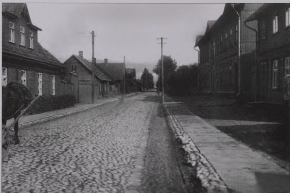
Raiņa iela 1935. gadā. Kreisajā pusē māja nr. 21, tā sauktā Freimaņa māja. Visas attēlā redzamās ēkas 1944. gadā nodega
