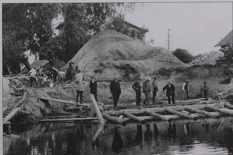
Rūjas tilta būve Valdemāra ielā 1924. gadā
