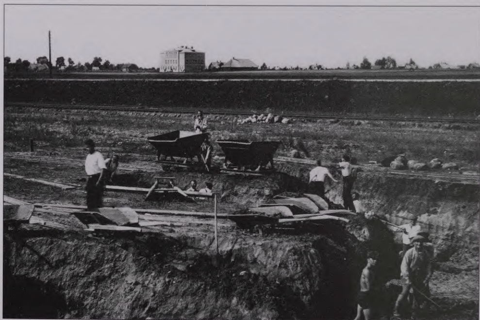
Bedres rakšana Rīgas — Rūjienas vilcienu lokomotīvju apgriešanas ierīcei 1935. gadā. Aizmugurē Rūjienas ģimnāzija
