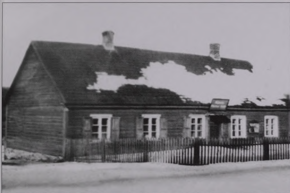
Raiņa ielā nr. 3 — Rūjienas pilsētas valdes nams līdz 1936. gadam, vēlāk tajā vietā uzcēla jaunu arhitekta A. Klinklāva projektētu celtni
