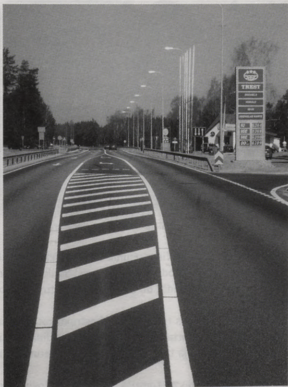
Automaģistrāle VIA BALTICA Lilastes posmā tika remontēta par ISPA līdzekļiem.
