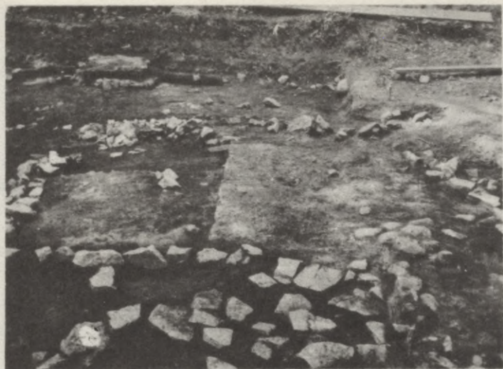
6. att. Ilgstoši izmantota pavarda vieta, griezumā zem vēlāka laika klona redzams senāks klons.
