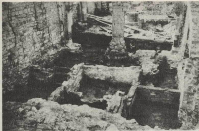
9. att. Baznīcas iekštelpa ar centrālās kolonnas pamatiem un kapličām.
