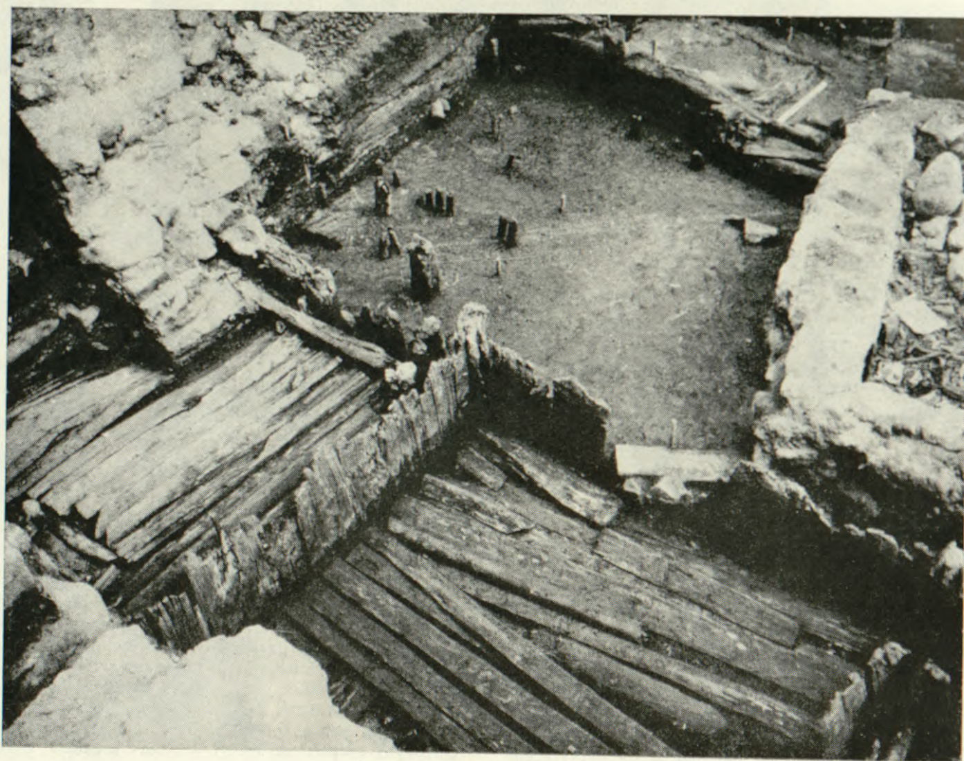
28. att. Peldu un Ūdensvada ielas izrakumos atklātās koka celtnes.
