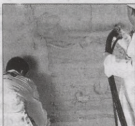
2.42. att. 2 mm bieža līmjavas slāņa uzklāšana ar apmešanas mašīnu
