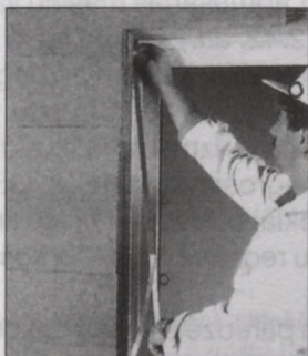
2.41. att. Salaiduma vietas ar loga (durvju) aplodu izveidošana
