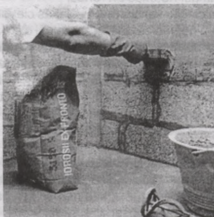
1.4. att. Hidroizolācijas IDROSILEX PRONTO ieklāšana
