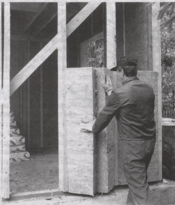
2.27. att. Minerālvates mīksto plāksņu iestrādāšana starp koka karkasa statņiem
