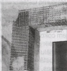
2.43. att. Logu (durvju) ailas pastiprinājums ar leņķveida bruņu sietu
