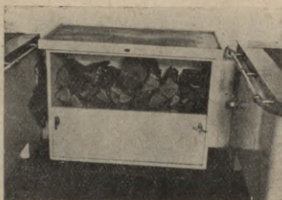
84. att. Skapīša veidīga malkas kaste. Kaste virsa pārsista ar skārdu un to lieto par darba galdu
