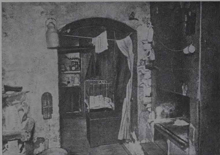
Dzīvokļa vajadzībām pārbūvētas malkas pagraba telpas Merķeļa ielā (ap 1930. gadu)
