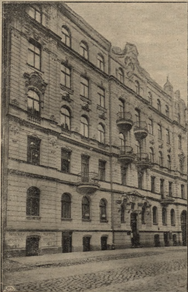
Latvijas lauksaimniecības centrālbiedrības nams Rīgā.
