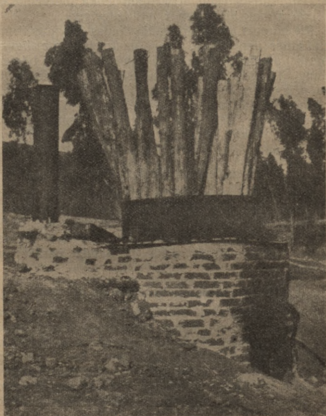
Zīm. 9. Dzelzs katls piepildīts ar konservējošu šķidrumu un tālī iemērktiem koka materiāliem.
