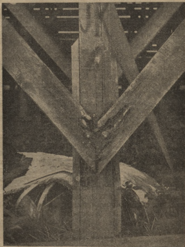
Zīm. 5. Pūšanas process attīstas daudz ātrāk koku savienojumos, kur vairāk uzkrājas mitrums.
