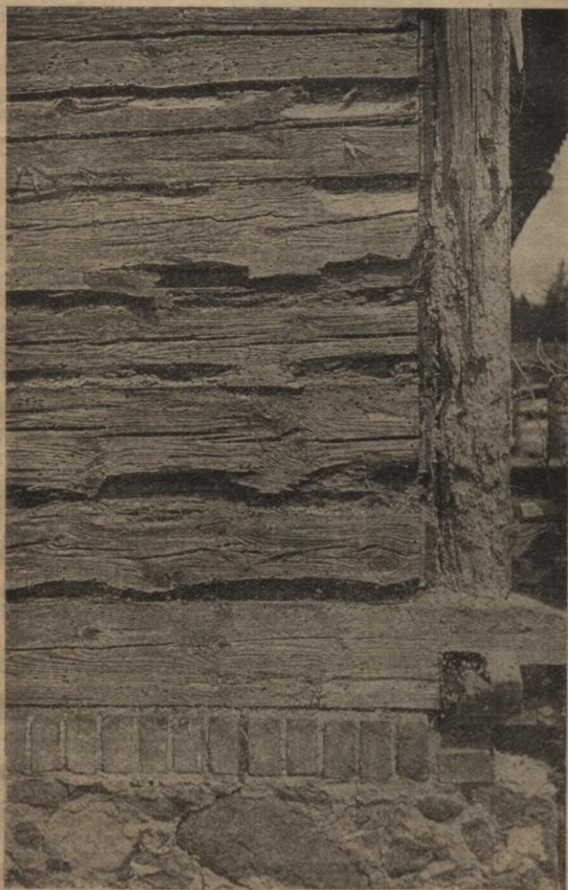
Zīm. 12. Ēku koksngrauža sagraustās ēkas stūris. (P. Pētersona uzņēmums 1927. g.).
