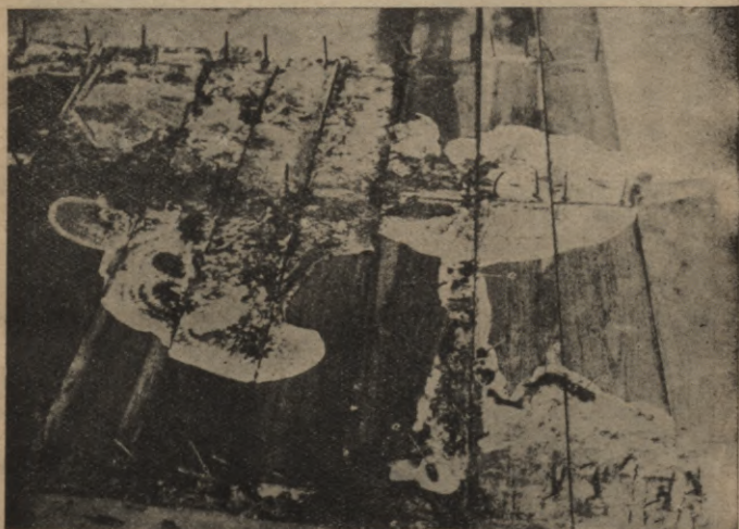
Zīm. 3. Slapjās mājas piepes sēņotne un augļķermeni (a) uz grīdas apakšpusēs. (Grīda sazāģēta un apgriezta otrādi).
