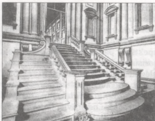
Mikelandželo. Kāpnes Sanlorenco bibliotēkas vestibīlā. 1524.–1559. g.
