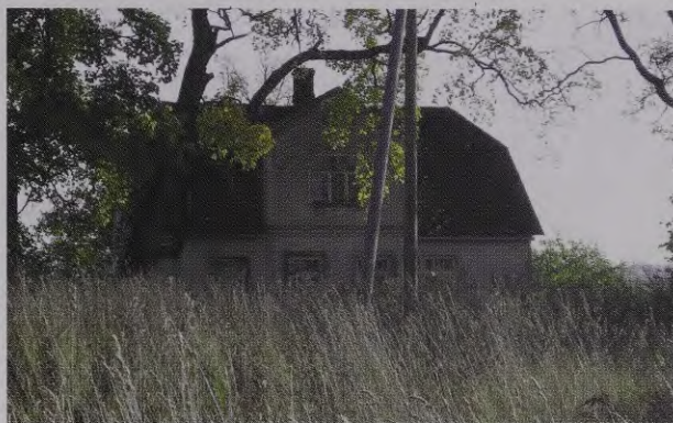
203. att. Nāguļi. R. Elkšņa foto. Sk. 103. lpp.
