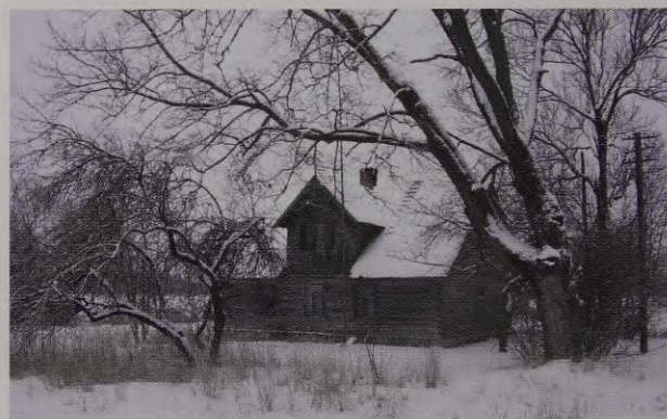
201. att. Muktiņi . R. Elkšņa foto. Sk. 103. lpp.
