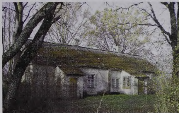
267. att. Bijusī Ūbeļu kalpu māja. R. Elkšņa foto. Sk. 122. lpp.
