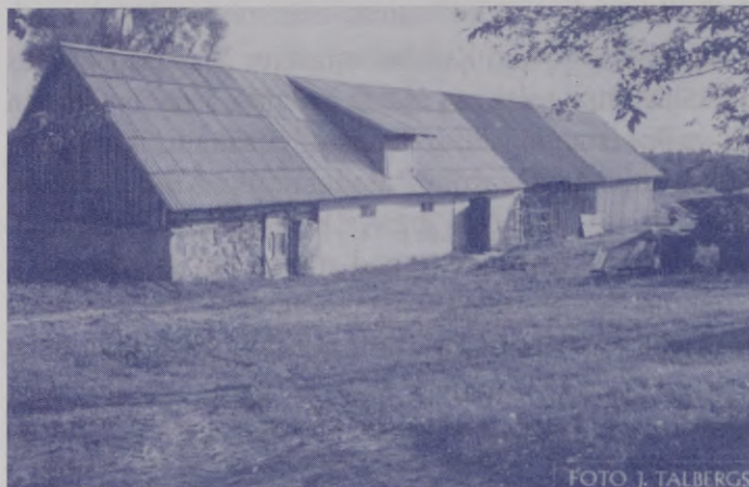
146. att. Kalna Skābuču saimniecības ēka. J. Tālberga foto. AiVMM 23902/92.
