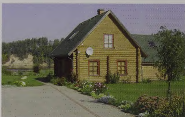
65. att. Baķi . M. Šternas foto. Sk. 65. lpp.
