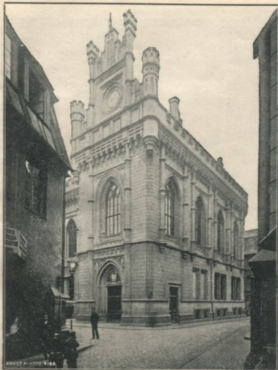
Домъ Большой гильдіи или гильдіи св. Маріи на малой Кузнечной ул. упоминается уже въ 1130 г. какъ „комната Мюнстеръ“. Въ 1854—59 г. онъ былъ съизнова перестроенъ, по плану академика Бейне, подъ руководствомъ архитектора Шеелъ, въ готическомъ вкусѣ, при чемъ сохранились только двѣ старыя комнаты, нижняя зала и такъ назыв. „Брачный покой“. Въ этихъ послѣднихъ достойны вниманія деревянная статуя Дѣвы Маріи съ Младенцемъ Христомъ и каминъ 1633 г. Верхняя зала прекрасно убрана (люстры) и содержитъ многочисленные щиты съ именами и гербами старшинъ.
