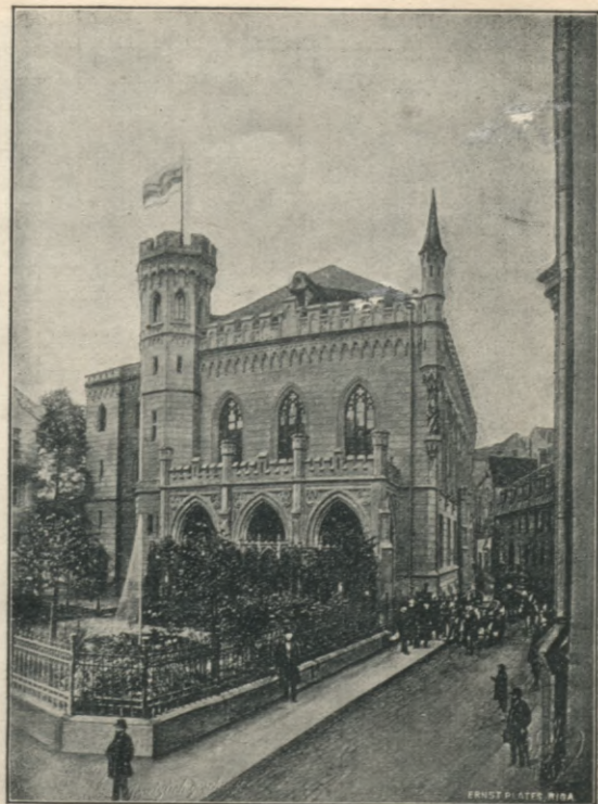
Домъ Малой гильдіи или гильдіи св. Іоанна на мал. Кузнечной ул. былъ построенъ въ 1864—66 г. въ готическомъ стилѣ, по плану городского архитектора Фелско, на томъ мѣстѣ, гдѣ прежде стоялъ старый, уже въ 1390 г. упомянутый домъ Малой гильдіи, такъ наз. „Комната Совѣтъ“. На углу главнаго верхняго фасада помѣщена статуя покровителя гильдіи, св. Іоанна. Въ нижнемъ этажѣ помѣщаются столовая, комната старшинъ, архивъ и т. д., въ первомъ этажѣ большая зала. Разныя достойныя вниманія драгоценности украшаютъ комнаты.
