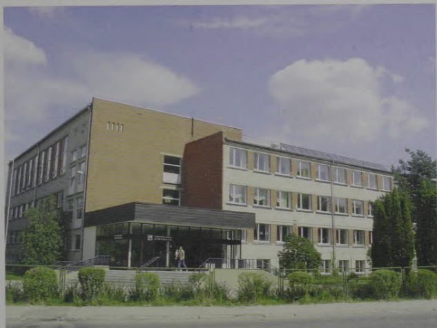
3. attēls. Saules enerģijas ieguves paneļi Aizkraukles ģimnāzijā
