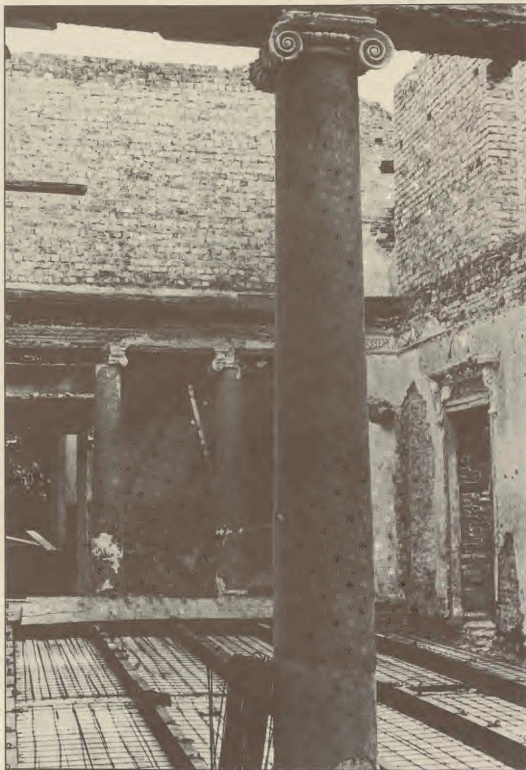
17. Ēdamzāle atjaunošanas darbu sākumā. Foto ap 1960. g. Столовая в начале восстановительных работ. Фото ок. 1960 г. Speisesaal am Anfang der Wiederherstellungsarbeiten. Foto um 1960.
