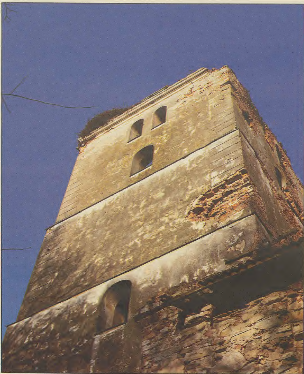
53. Baznīcas tornis. Шпиль церкви. Kirchenturm.
