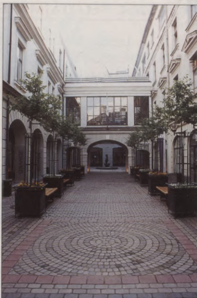
"Berga bazārs". Rekonstrukcija. Arhitekta Z. Gaile. 1994–1998
