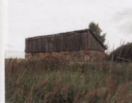
Vecbrūmeisteri . Kādreiz bija lielas mājas ar 103 ha zemes. Ēkas gājušas bojā II pasaules kara laikā. Attēlā redzami mūri ir vienīgā liecība par to, kas šeit bijis. Jaunajam saimniekam pēc 90. gadu zemes reformas rocība neļāva uzcelt māju. E 41 brūmestēri
