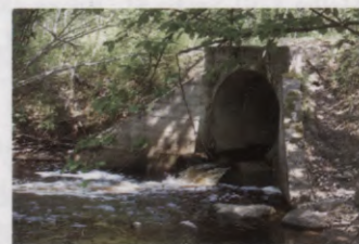
Vedzes caurteka zem ceļa pie Baznīckalna.
