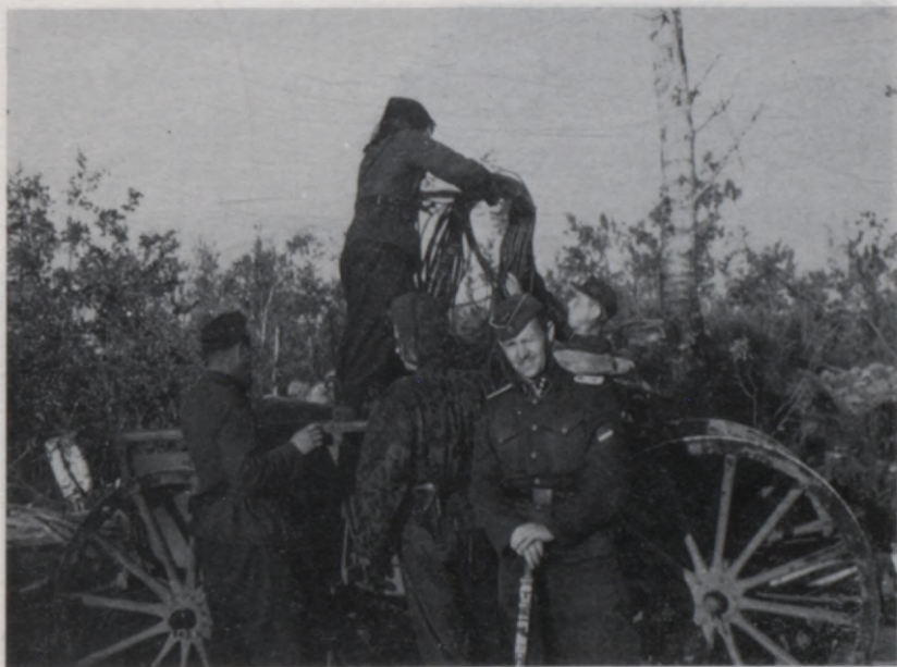
Skaļruņu uzstādīšana propagandas „cīņai”. Priekšā ar spieķi vltņ. Bergs
