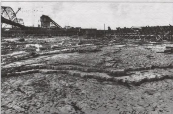
1937. gada 22. jūlijā atsūkņēts ūdens līmenis (redzami Daugavas gultnes dolomītu atsegumi), uzcelts pagaidu aizsprosts
