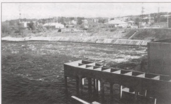
Ķeguma HES kameru tipa zivju ceļš, 1998
