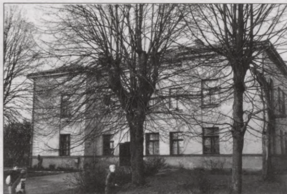
1948. gadā celtais ugunsdzēsēju depo. Otrajā stāvā bija HES kantoris, pirmajā – garāža ugunsdzēsēju mašīnām un 2 dzīvokļi. Sešdesmitajos gados ēka pielāgota dzīvokļiem (tagadējā Skolas ielā 1)
