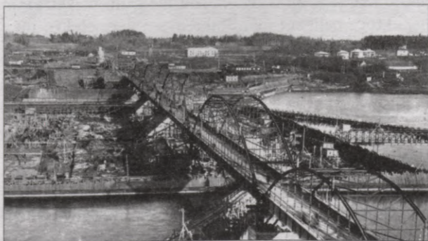
Tilts un spēkstacijas būvvieta 1937. gada oktobrī
