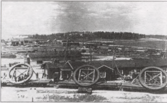
Uz dzelzceļa sliedēm HES turbīnas ģeneratori. Labajā pusē instrumentu noliktavas un elektrodarbnīcas, 1938
