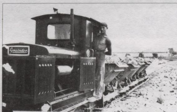
Dizellokomotive vagonetēs piegādā granti no karjera būvdarbu veikšanai
