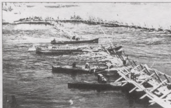
Ķeguma HES būvbedres norobežošanas darbi, 1937
