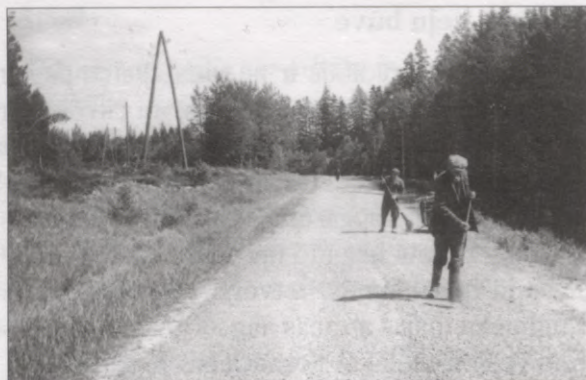
Ceļa kopšana sešdesmito gadu beigās. Pēc šķembu uzbēršanas brauktuve ar slotu "jāizpucē"
