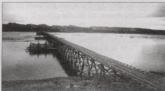
Uz koka stēķiem pārmestais tilts, 1936
