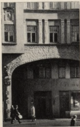
Tres nams Ļeņina ielā 88. Fasādes fragments. 1910. g. J. Alksnis.
