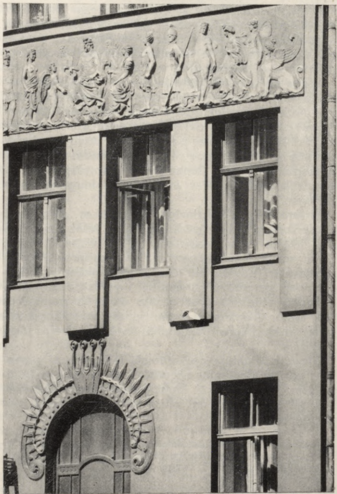
Īres nams Lāčplēša ielā 61. Fasādes fragments. 1909. g. R. Donbergs.
