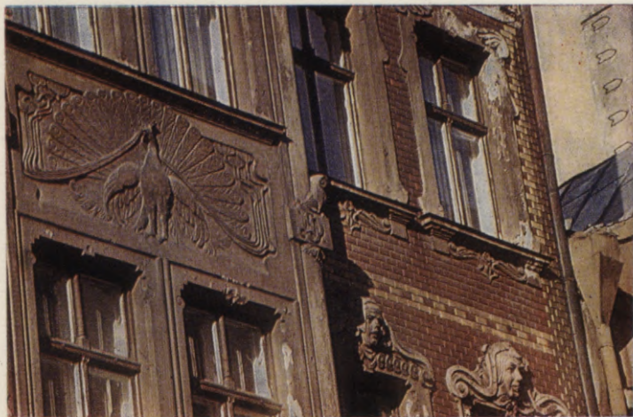
Tres nams Smilšu ielā 2. Fasādes fragments. 1902. g. K. Pēkšēns.
