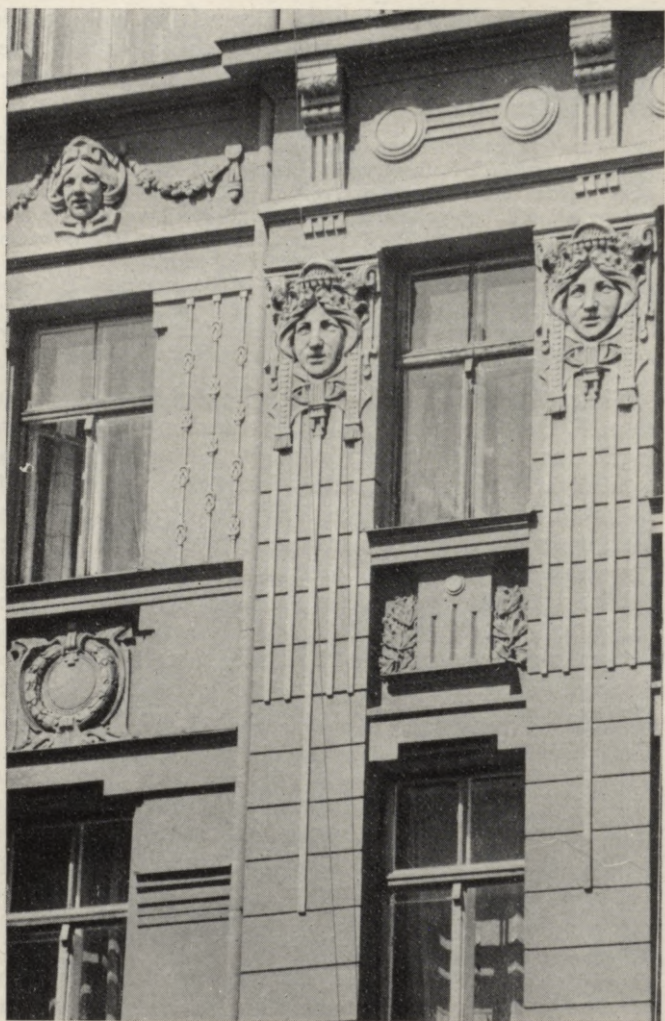
Īres nams Ļeņina ielā 105. Fasādes fragments.
