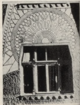
Tres nams Suvorova ielā 26. Fasādes fragments.
