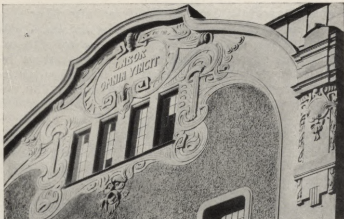
Tres nams Kirova ielā 23. Fasādes fragments.
