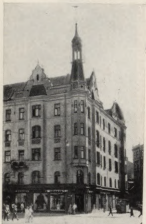
Tres nams Avotu ielā 1. 1904. g. K. Pēkšēns.
