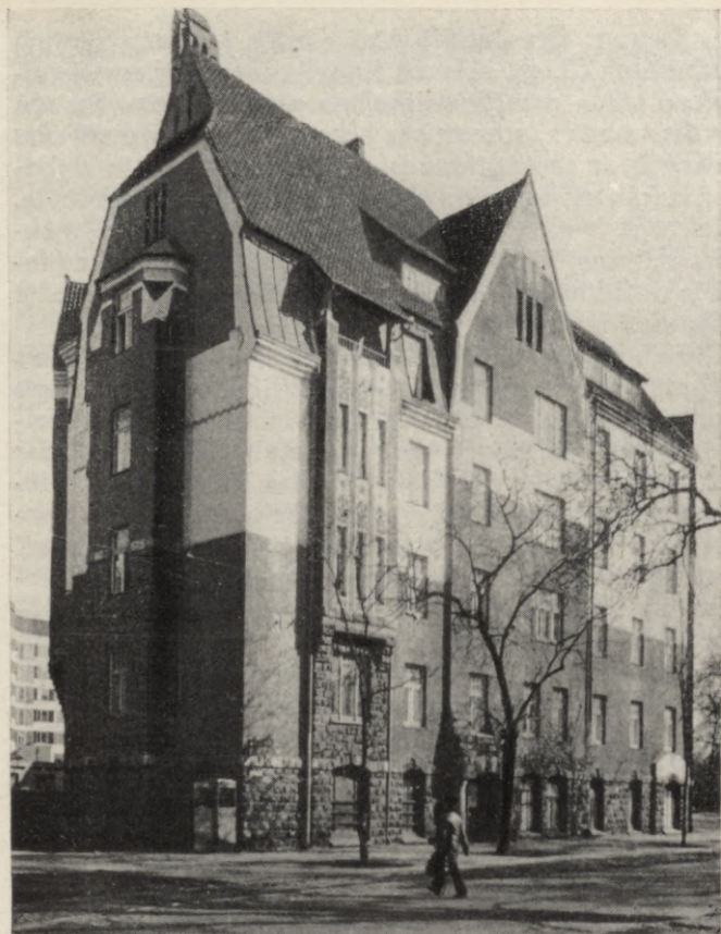
Īres nams Kronvalda bulvārī 10. 1907. g. K. Pēkšēns, E. Laube.
