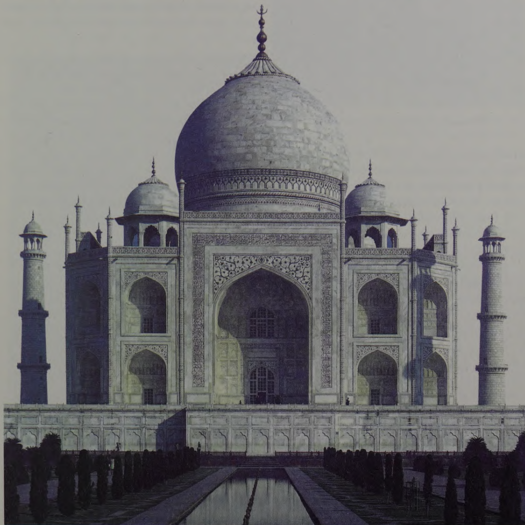
130. att. Tādžmahalas mauzolejs Agrā.
