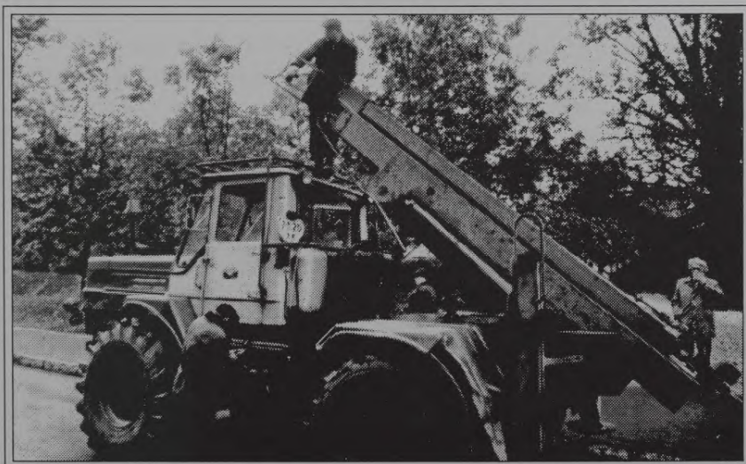
Cēsu sakarnieku un Ziemeļu elektrisko tīklu darbinieku kopīgi būvētais stabu urbis - pacēlājs. Izgatavots Valmierā. 80. gadi.
