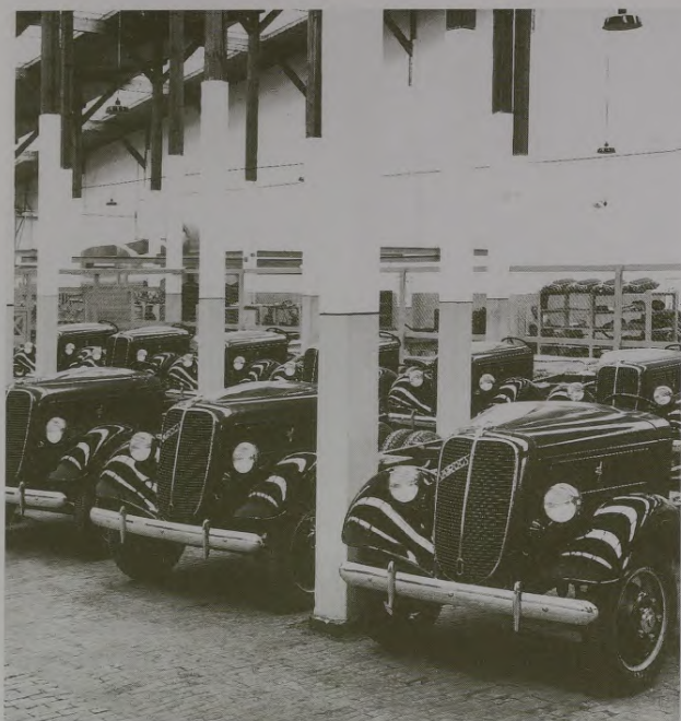
"Ford-Vairogs" montētās kravas automobiļu šasijas. 1937.g. Assembled "Ford-Vairogs" truck chassis. 1937.
