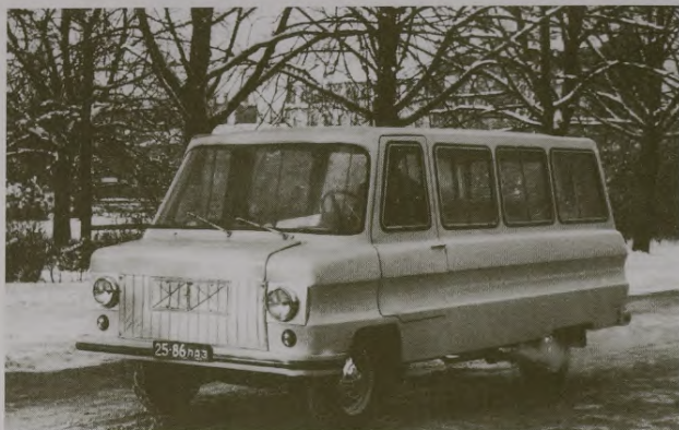
Mikroautobuss ar plastmasas virsbūvi. NAMI institūta (Maskavā) projekts. Realizācija uz "RAF" šasijas. 1973. g. A microbus with a plastic body built on a "RAF" chassis. A project of the NAMI Institute in Moscow. 1973.
