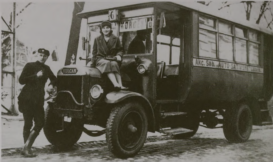
Viens no A. Frīzena fabrikā būvētajiem Rīgas autobusiem. Angļu "Vulcan" šasija. 1930.g. One of the buses built on an English "Vulcan" chassis at A. Friesen's factory in Riga. 1930.
