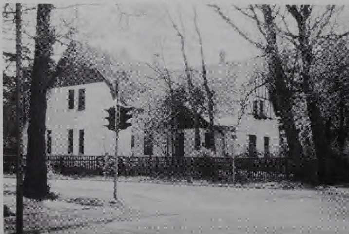
Bij. Ev. lut. mācītāja māja Vasarnīcu ielā 1987. g.
