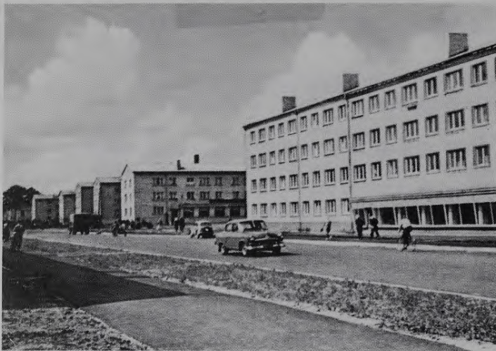
Pēckara jaunceltnes Brīvkalna ielā (agrāk Sarkanmuižas dambis ceļā uz staciju).
