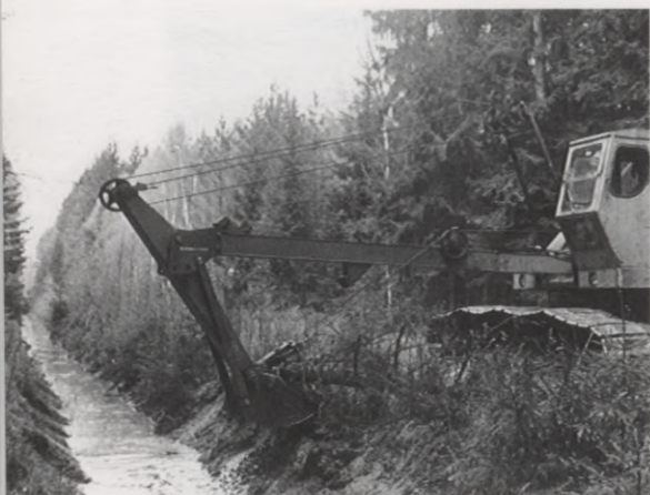
2. attēls. Nosusināšanas grāvju atkārtota atīrīšana
