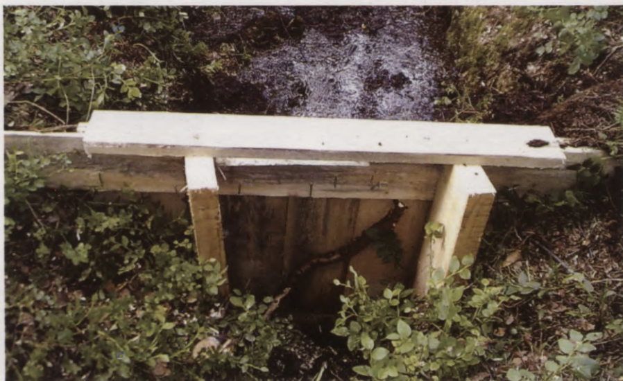
10. attēls. Dēļu konstrukcijas dambis
