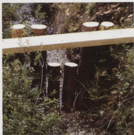
11. attēls. Balķu konstrukcijas dambis (M. Paleja foto)
