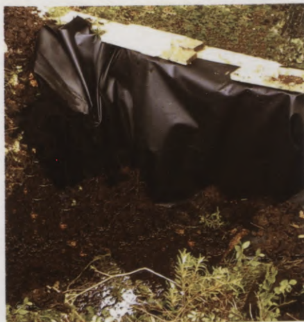
12. attēls. Balķu konstrukcijas dambja pārklājums ar plēvi
