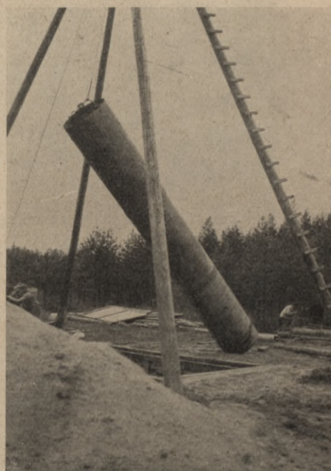
Zīm. 13. 1000 m/m apvalkcaurules ielaišana urbšanas šachtā.
