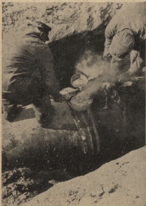
Zīm. 31. Uzmāvu aizliešana ar svīnu „vienā laidā”.
