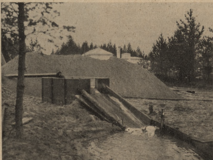
Zīm. 13b. Filtrakas Nr. 52 nosūkņēšana ar 35 l/s.
