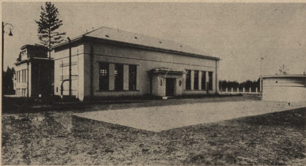
Zīm. 24. Jaunās sūkņu st. un krājakas skats (pa kreisi transformatora māja).
