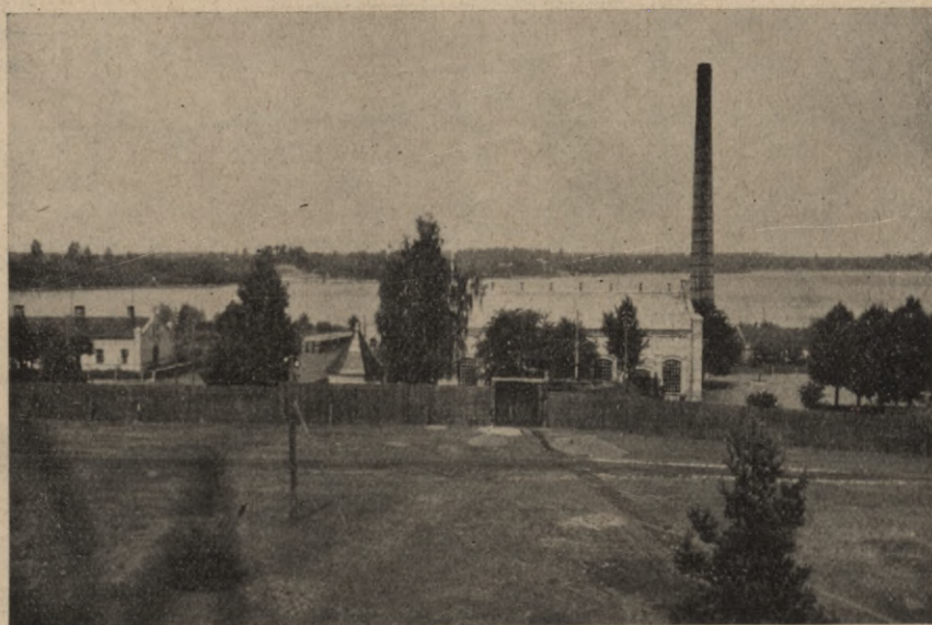
Zīm. 8. Bukultu stacijas kopskats.
