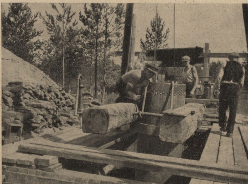
Zīm. 13a. 800 m/m apvalkcaurules sagatavošana iegremdēšanai.
