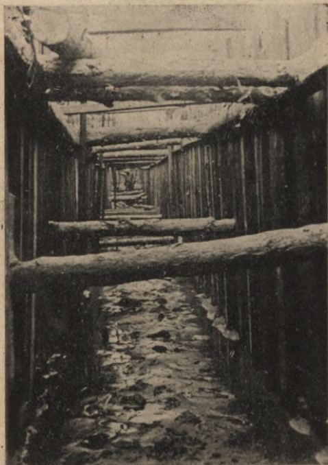
Zīm. 17. • Būvbedres nostiprināšana ar Krupa tērauda riev sienām.
