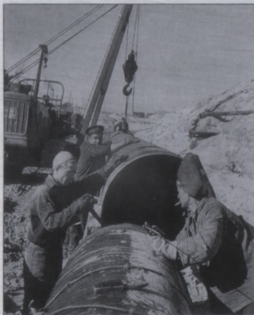
Ventspils nafta . Naftas cauruļvada būve Ventspils ostā 1963. gadā
