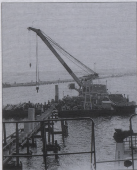
Baltijas jūras hidrotehniskās celtniecības un montāžas darbu trests. Piestātnes būve Ventspils jūras tirdzniecības ostā 1975. gadā
