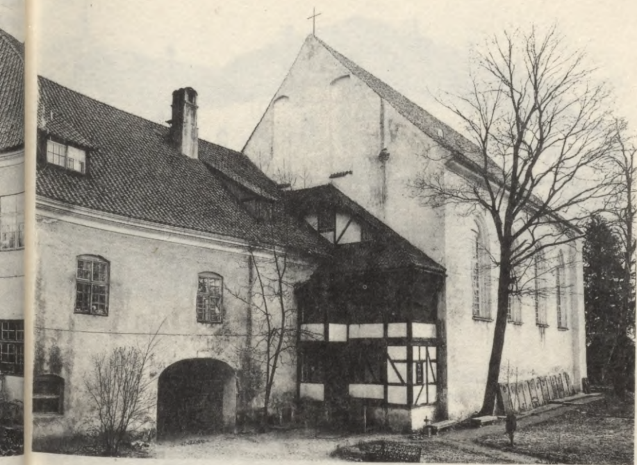
Lielstraupes muižas pils. Pie baznīcas redzama pildrežģa izbūve, kurā atradās kāpnes. Tas ir tīri funkcionāls veidojums, kurš nepretendē uz īpašu māksliniecisko vērtību
