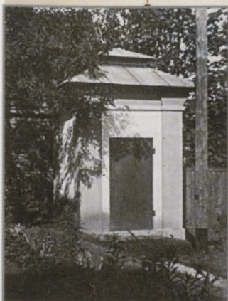
■ Transformatoru punkts Z. Meierovica ielā Tukumā, 1937.gadā
