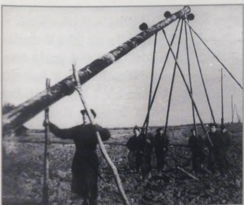
■ Elektropārvošanas līniju balstu sagatavošana un celšana, 50.gados
