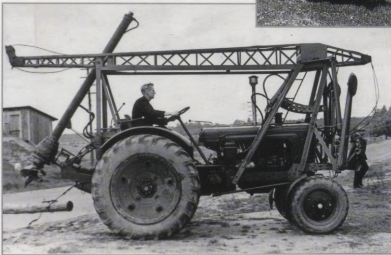
■ Traktors Belarus ar balstu bedru urbšanas mehānismu
