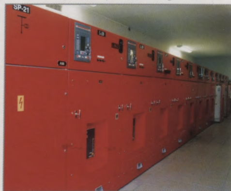
■ Tukuma apakšstacijas 20 kV slēgiekārtā
