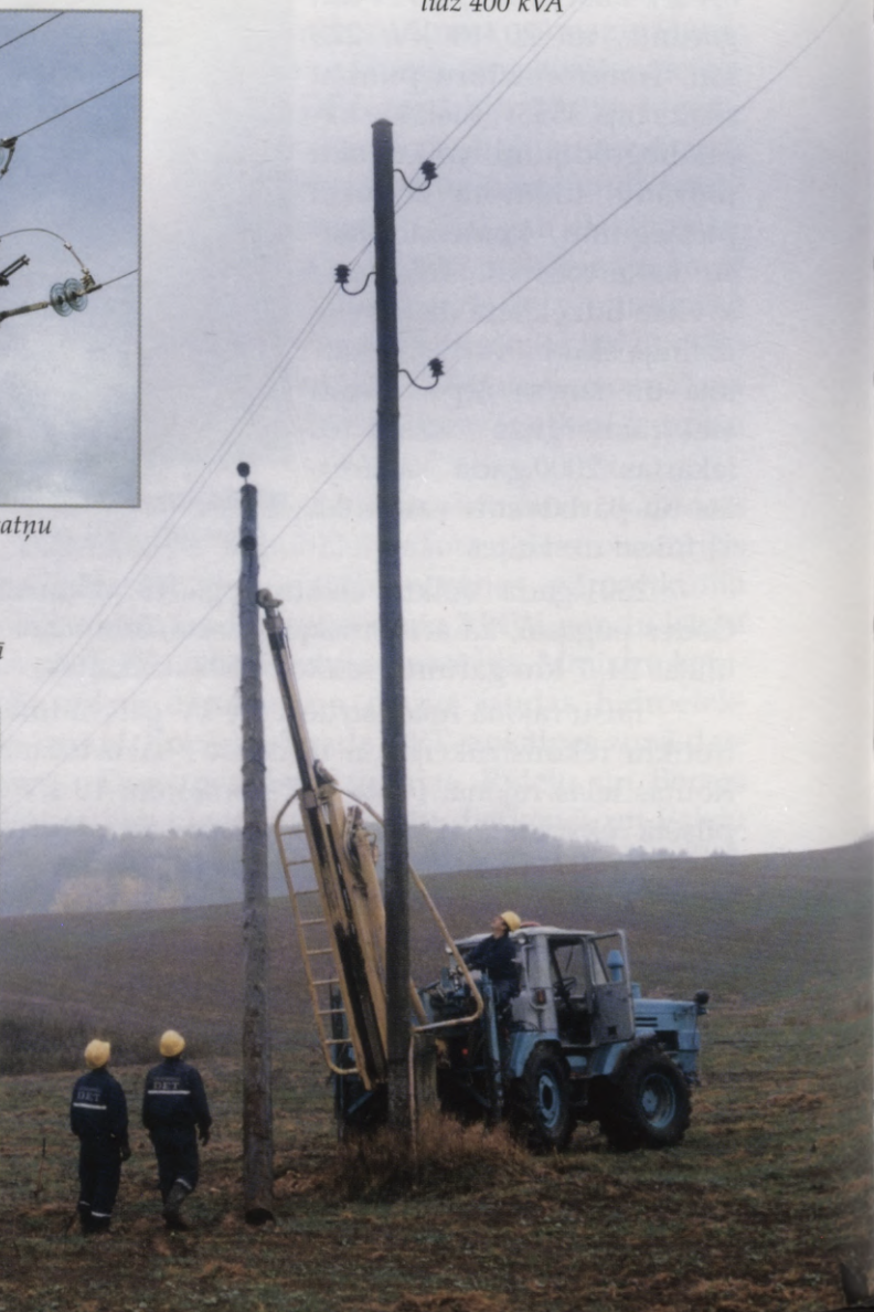
■ Transformatoru punkts "H" veida balstā ar jaudu līdz 400 kVA
