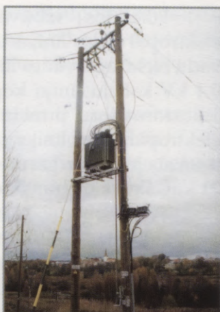
■ Transformatoru punkts "H" veida balstā ar jaudu līdz 400 kVA
