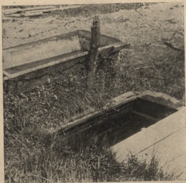
Ganībās izbūvēta aka un iesists sūknis ar dzirdišanas sili
