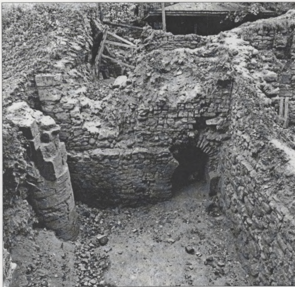
5. att. Siguldas pilsdrupas. Rietumu korpusa austrumu sienas fragments ar pagrabstāva pārsedzes atbalsta atkāpi un durvju ailu F izrakumu laukumā. Skats no rietumiem
