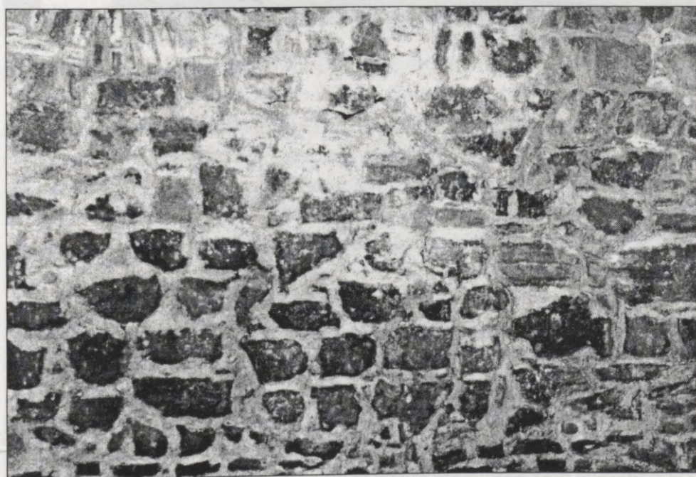
10. att. Rīgas pils Svina torņa mūrējums no jaukta, salasīta materiāla 16. gadsimtā
