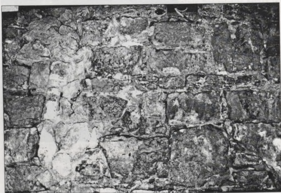
9. att. Rīgas pils dienvidu korpusa pagraba sienas mūrējums no dolomīta kvadriem ar izteiktu rindu principu 14.–15. gadsimtā
