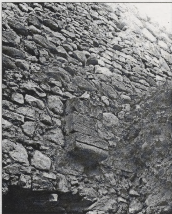
27. att. Rietumu korpusa atraktā transversālās arkas konsole.
