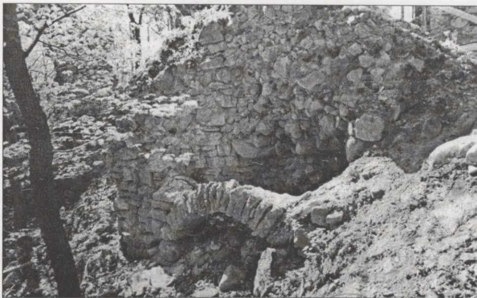
16. att. Rietumu korpusa austrumu sienas arka zemes līmenī. 1968. gads.
