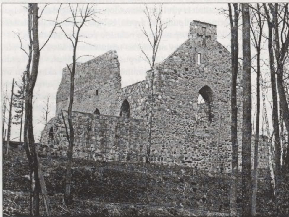
18. att. Pils dienvidu fasāde pēc restaurācijas.
