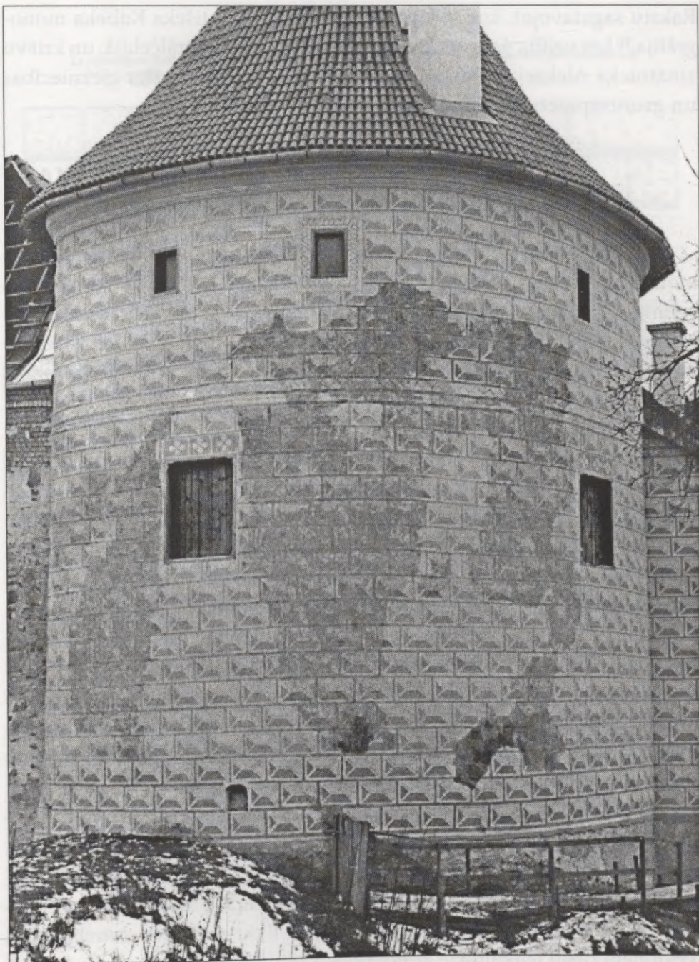
2. att. Bauskas pils ziemeļaustrumu torņa fasāde pēc restaurācijas. 2001. gads. V. Leijeres foto
