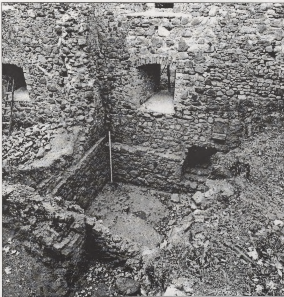
7. att. Siguldas pilsdrupas. Rietumu korpusa rietumu sienas atsegums ar logu un konsoli pirmā stāva līmenī un lūku pagrabstāva līmenī, kā arī atkāpi pagrabstāva pārsedzes atbalstam F izrakumu laukumā. Skats no ziemeļaustrumiem
