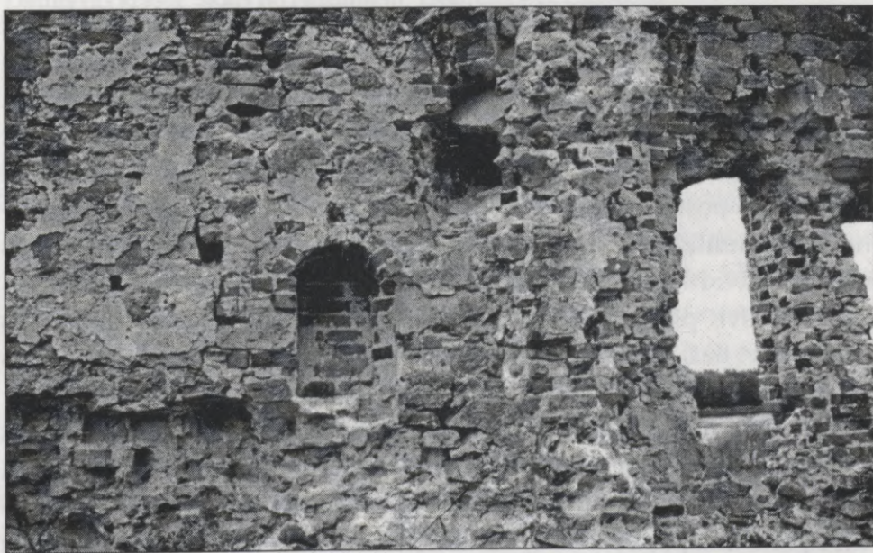
9. att. Aizkraukles pilsdrupas. Sienas niša, velvju pēda un dūmvads – skatā no ziemeļaustrumiem. 1998. gads
