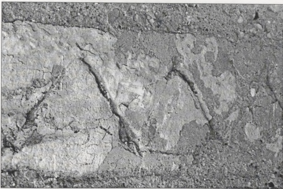
11. att. Kalķošanas un atkārtotas sgrafito izgriešanas pēdas Bauskas pils ziemeļaustrumu torņa fasādes augšdaļā. 1998. gads. V. Leijeres foto
